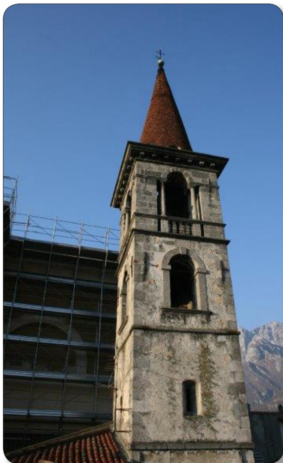
Il “Campaniletto” prima del restauro
