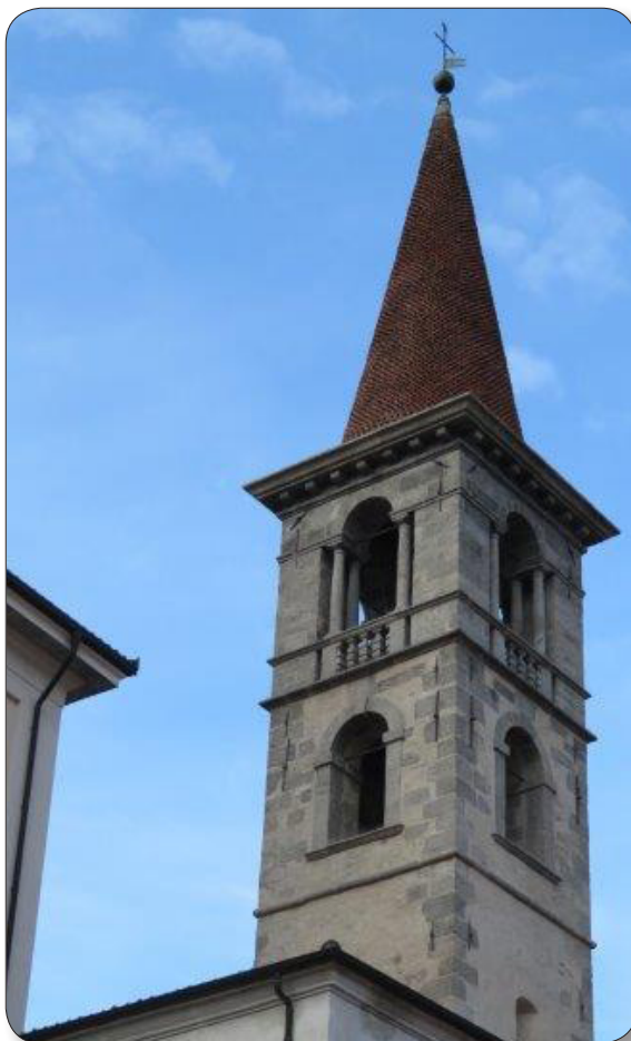
Il “Campaniletto” dopo il restauro
